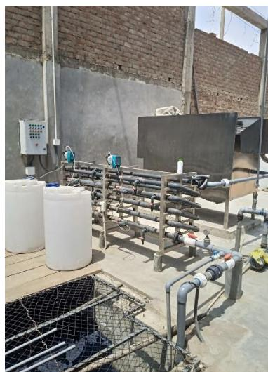
*Nota.* La imagen muestra el sistema de coagulación en línea
